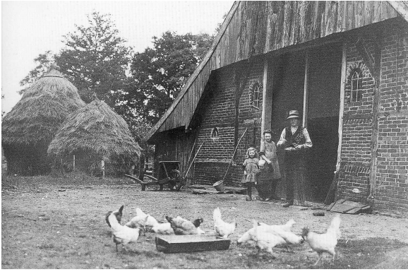
Achtergevel van een oude boerderij met een traditioneel ingericht erf. De achtergevel is nog uitgevoerd in vakwerk dat met metselwerk gevuld is. De topgevel heeft verticaal beschoot.
