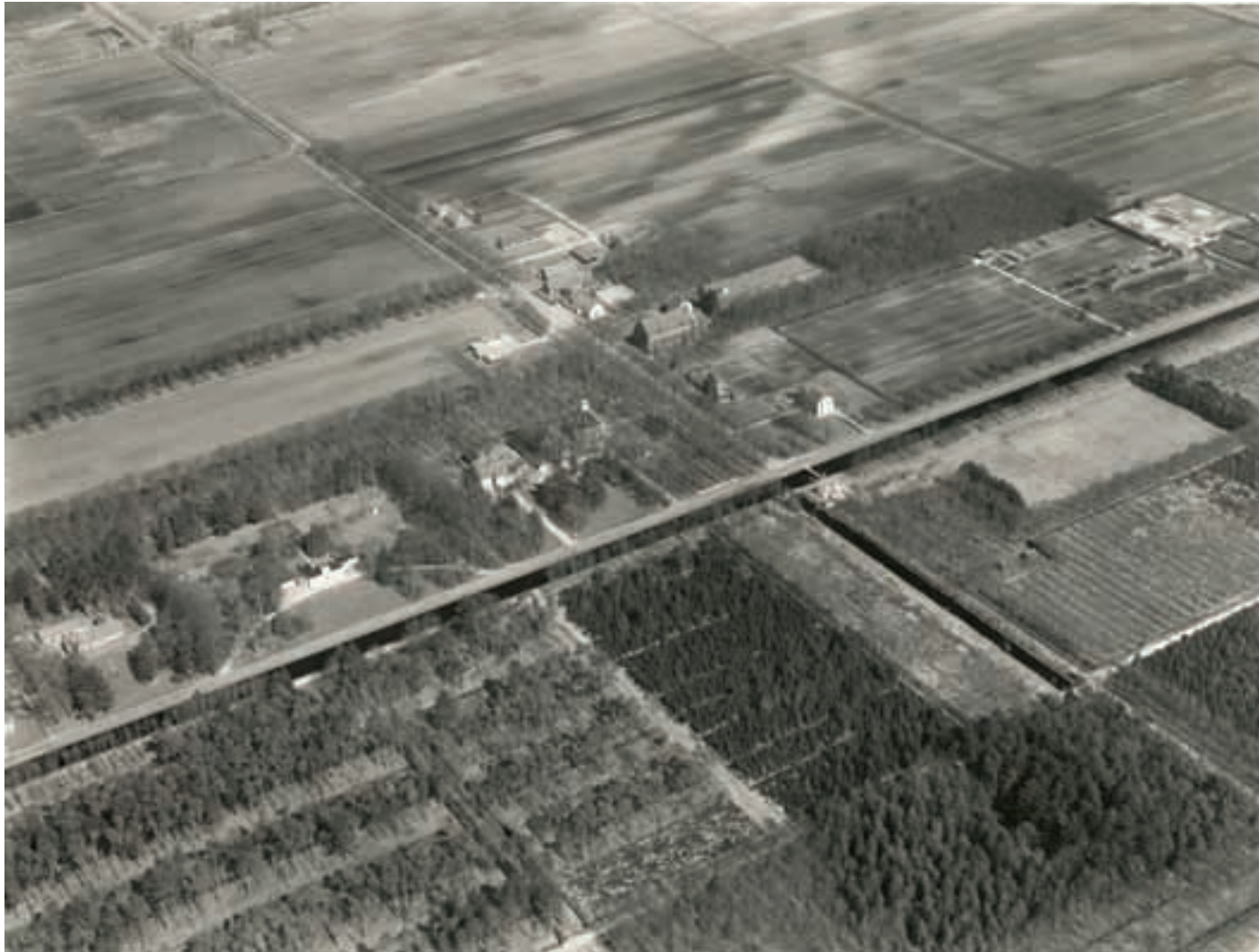
De bebouwingszone aan de Koloniewaart en Hoofdweg, omstreeks 1965. Van links naar rechts de voormalige synagoge, directeursvilla 'Klein Soestdijk', het Verenigingsgebouw, de N.H.-kerk, de nieuwe R.K.-kerk (met daarachter aan de Kerklaan de oude R.K.-kerk, de Kerkhoeve, de openbare basisschool en tegenover gelegen sportcentrum), pastorie Zegenrijk, kwekerij en zwembad. (Bron: NGM, VG0801016).
