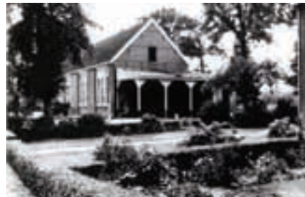
School Leerlust aan de Generaal van den Boschweg 9. Op de voorgrond de tuin bij 'Orde en tucht' met hagenstructuur. (Bron: NA).
