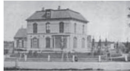
Het directiehotel, kort na de bouw en aanleg van de tuin. De aangeplante bomen zijn nog voorzien van plantpalen. (Bron: NGM, VG0104004).
