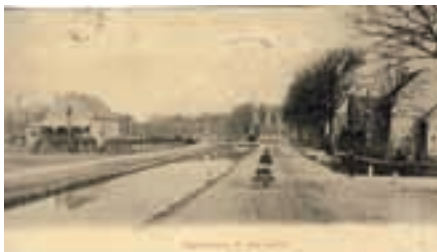
De weg langs de Vijfde Wijk, uitkomend op het Tweede Gesticht, ca. 1903. Links de school Leerlust, rechts omhaagde tuinen bij woningen en bomenrij. (Bron: NA).
