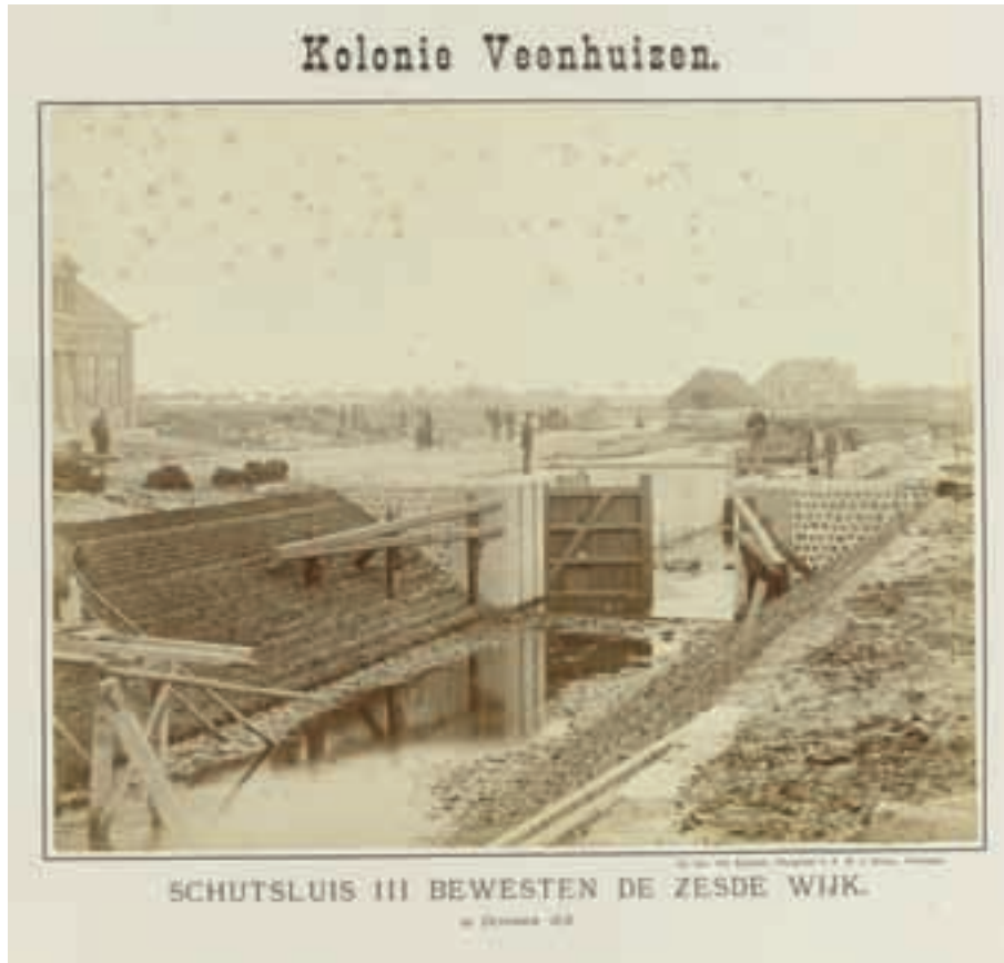
'Schutsluis III bewesten de zesde wijk, 19 oktober 1878'. De foto geeft de bouw van de tweede generatie schutsluizen weer. Links de bijbehorende sluiswachterswoning en links op de achtergrond de schaapskooi en schaapherderswoning. Langs dit deel van de Kolonievaart lijkt geen beplanting aanwezig. Op de achtergrond zijn wel de bomenrijen langs de Vijfde wijk te zien. (Bron: NA).
