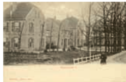
Zicht op het werkgesticht aan de Plantsoenstraat (vanuit het zuiden), ca. 1900. Rondom het gebouw is een soort plantsoen aangelegd met bomenrij, naaldbomen en heestervakken. (Bron: NGM, VG0117001).
