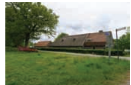
Boerderij Het Essererf op de kruising van de Eikenlaan en de Hospitaallaan (2020).
