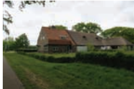
Boerderij Het Esser erf aan de Hospitaallaan (2020).
