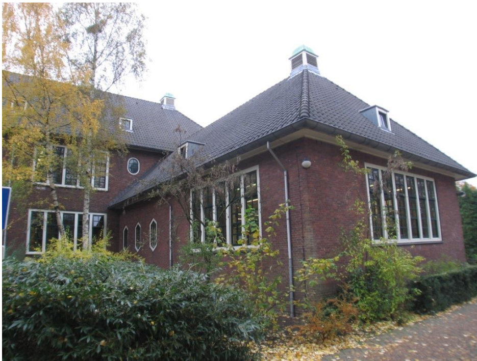
De voorgevel (zuidwest) met de rechter zijvleugel.
