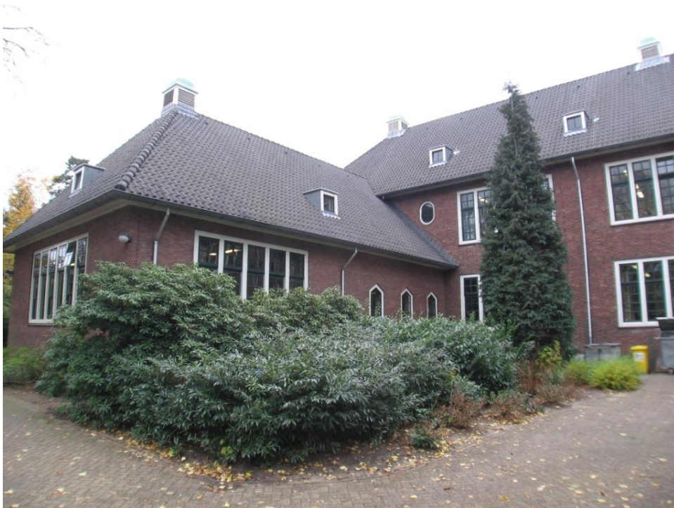
De voorgevel (zuidwest) met de linker zijvleugel.
