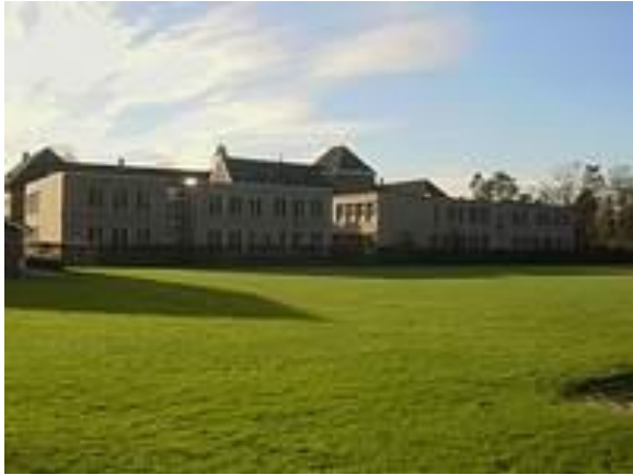
De achtergevel (noordoost), volledig aanzicht.
