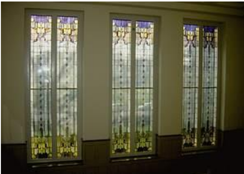
Glas-in-lood vensters in de voorgevel/ centrale trappenhuis
