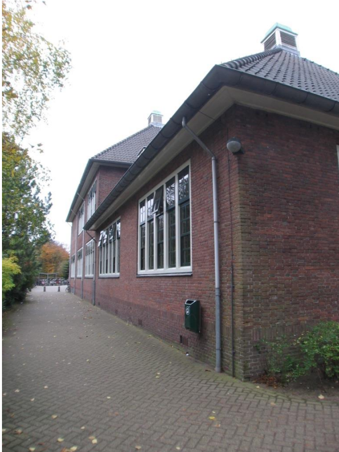
De linker zijgevel (noordwest) gezien vanuit het zuiden.
