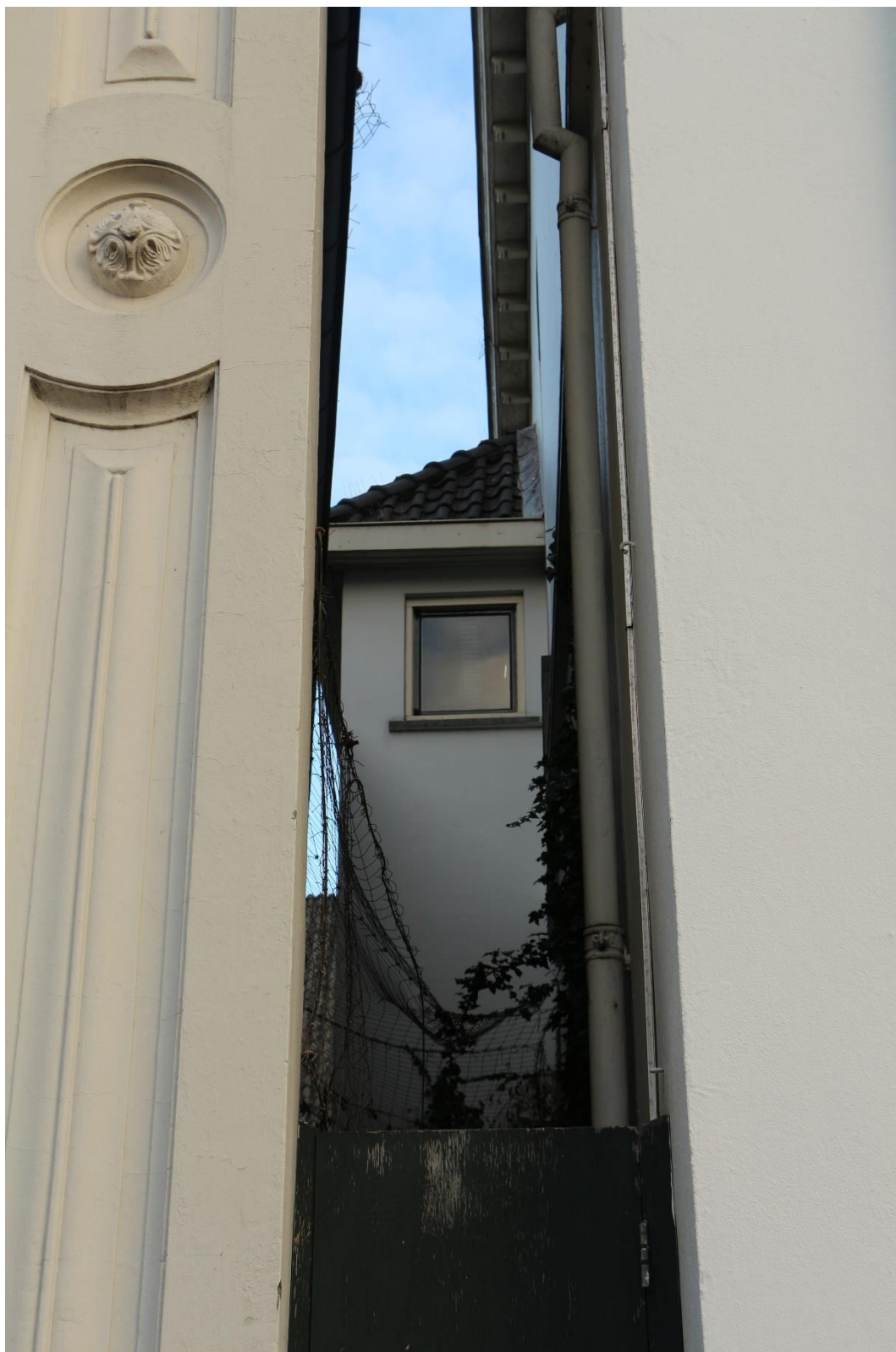
Afb. 4 Zicht langs de linker zijgevel, met op de achtergrond de aanbouw tegen deze gevel
