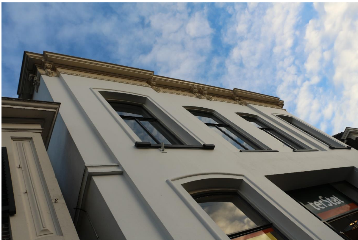
Afb. 5 Detail bovenzijde voorgevel
