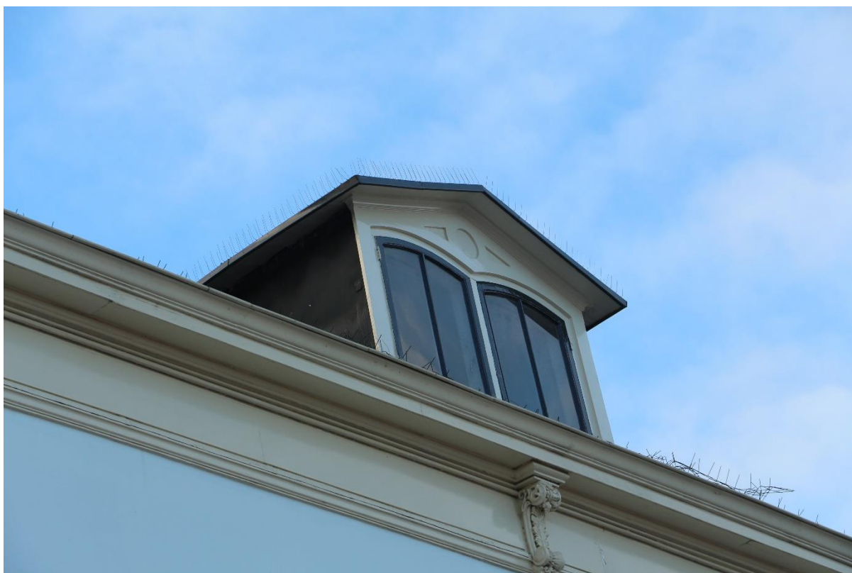
Afb. 8 Detail dakkapel boven de achtergevel
