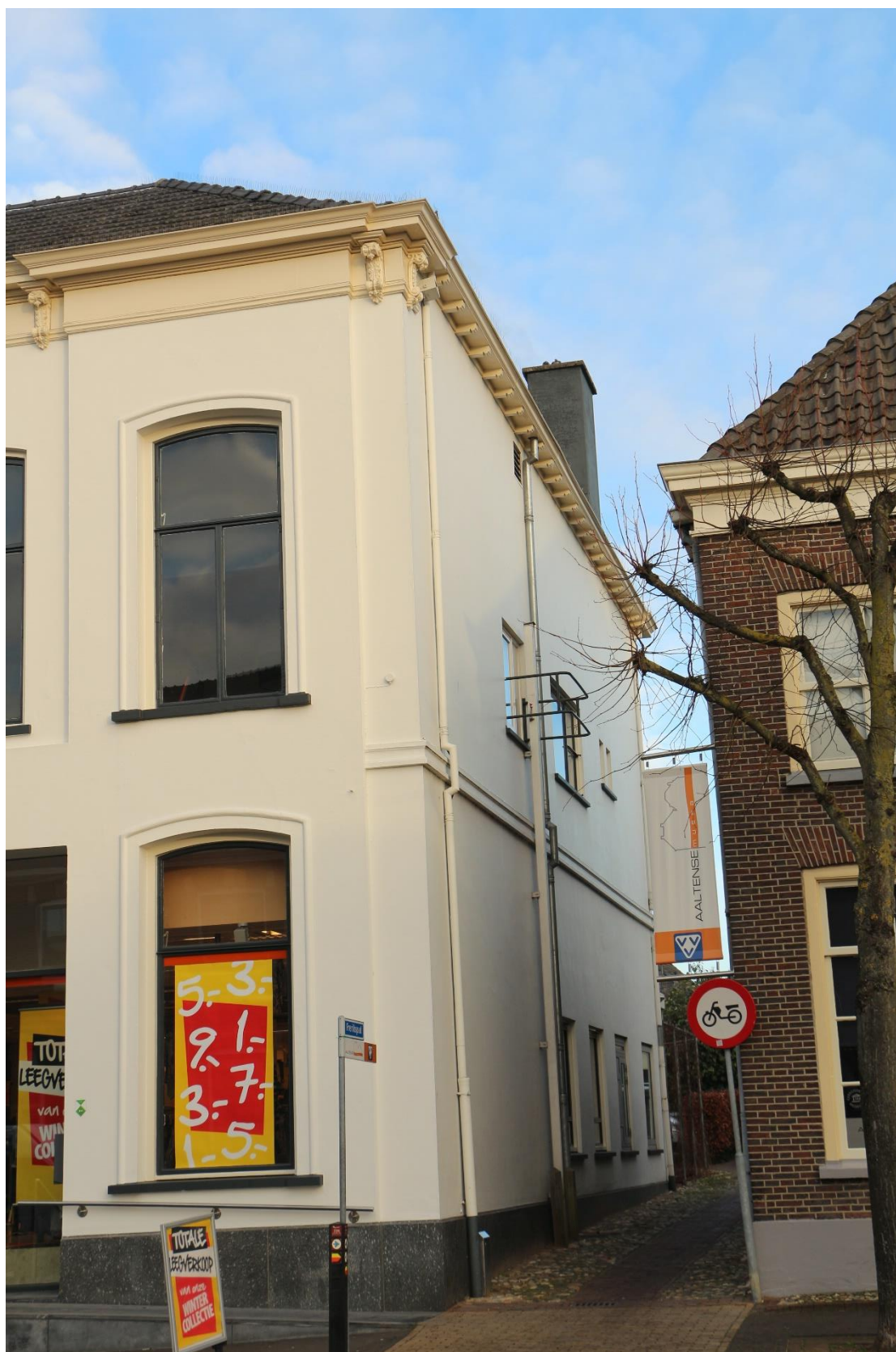
Afb. 3 Overzicht van de rechter zijgevel
