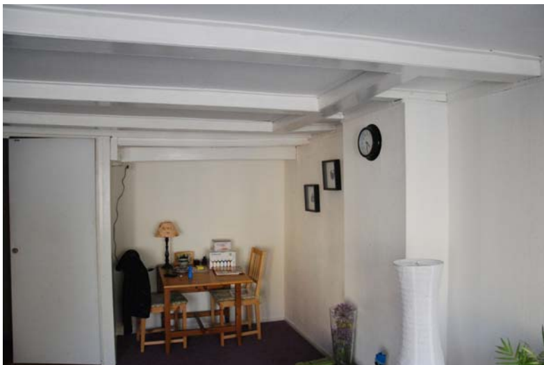
Afb. 10 Grote Kerkplein 12-13: de insteekverdieping. Ook hier werd in de 18e eeuw de balklaag vernieuwd. Tegen de rechter zijmuur kwamen schouwen.
