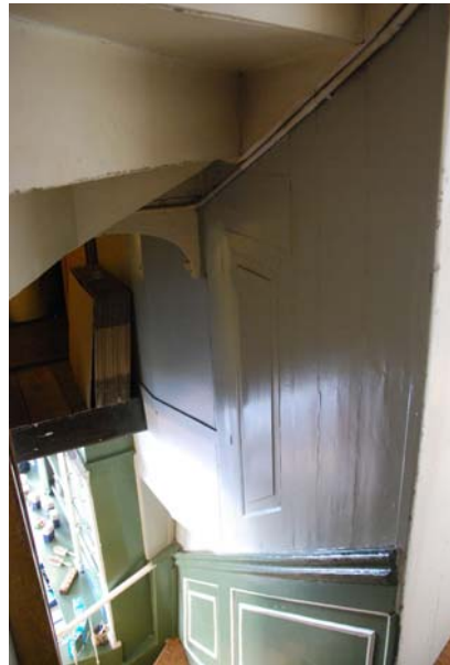
Afb. 7 Grote Kerkplein 12-13: vroeg 17e-eeuws sleutelstuk onder de balklaag boven het voorhuis.
