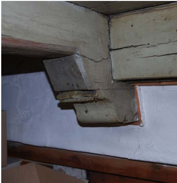
Afb. 7 Grote Kerkplein 12-13: vroeg 17e-eeuws sleutelstuk onder de balklaag boven het voorhuis.
