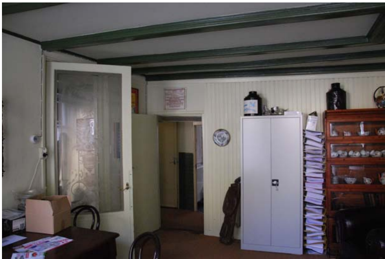
Afb. 9 Grote Kerkplein 12-13: achterhuis begane grond. De balklaag is in de 18e eeuw vernieuwd.
