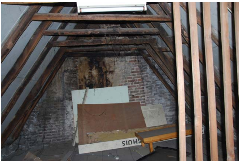
afb. 13 De kapconstructie boven het rechter achterhuis.
