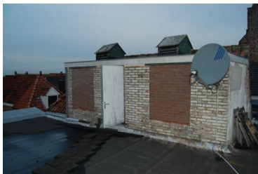
Gemetselde dakopbouw waarin twee grote duivenhokken ondergebracht zijn.
