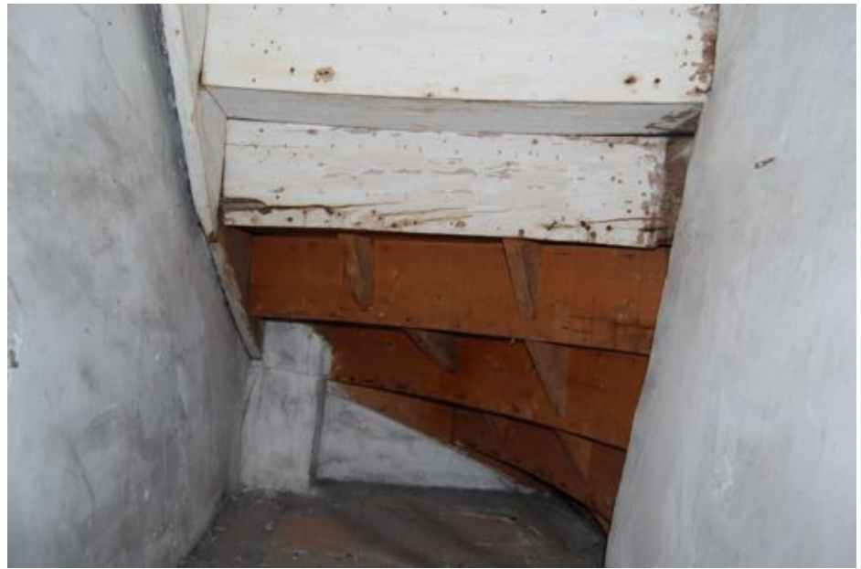
Eiken bordestrap van nummer 6 op de begane grond. Het onderkwart op de begane grond, dat voorzien is van een rijk gedecoreerd klauwstuk, is later toegevoegd. Aan de onderzijde van de trap (foto rechts) is goed zichtbaar dat dit deel in naaldhout uitgevoerd is.
