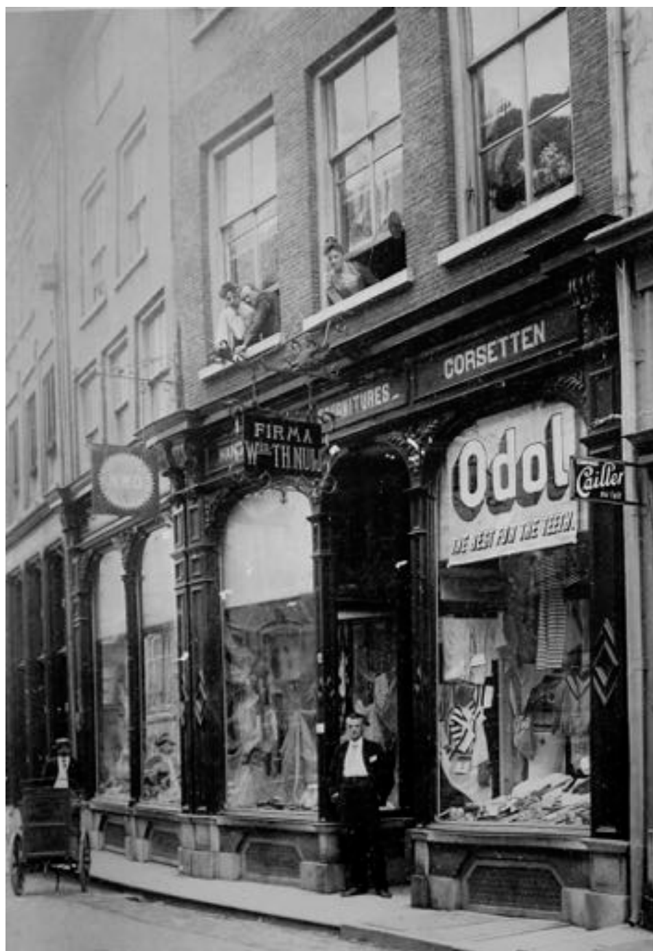
Dubbele winkelpui van nummer 6 en 8. Deze pui is waarschijnlijk gerealiseerd bij de verbouwing en uitbreiding van de winkelruimte op de begane grond omstreeks 1900.
