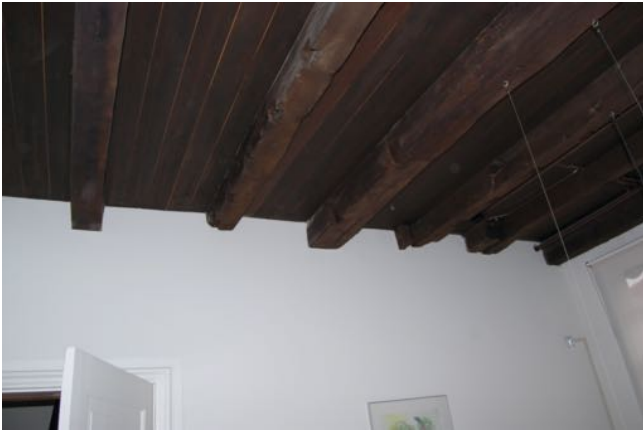
Links de oplegging van de voormalige zolderbalklaag op de gangmuur op de verdieping. rechts de achtergevel van nummer 6 met op de voorgrond de uitbreiding van de winkel die omstreeks 1900 plaatsgevonden heeft.
