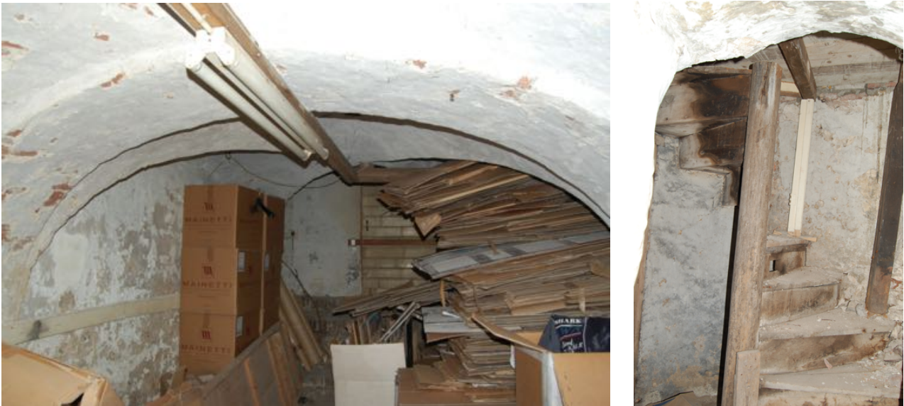
Links de kelder met kruisgewelven aan de voorzijde en rechts de houten spiltrap in de kelder links achter.
