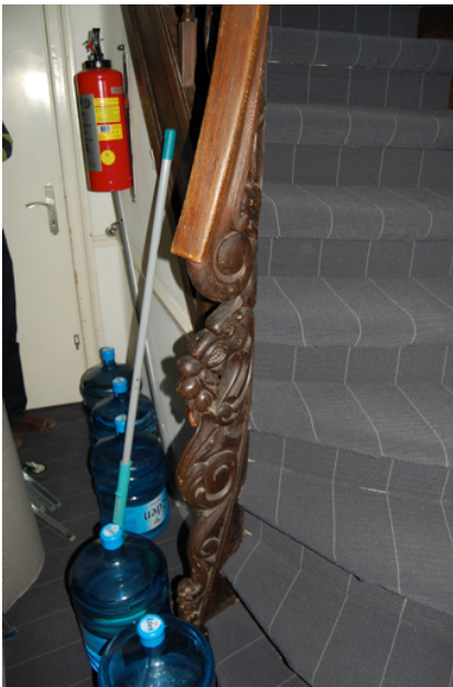
Eiken bordestrap van nummer 6 op de begane grond. Het onderkwart op de begane grond, dat voorzien is van een rijk gedecoreerd klauwstuk, is later toegevoegd. Aan de onderzijde van de trap (foto rechts) is goed zichtbaar dat dit deel in naaldhout uitgevoerd is.
