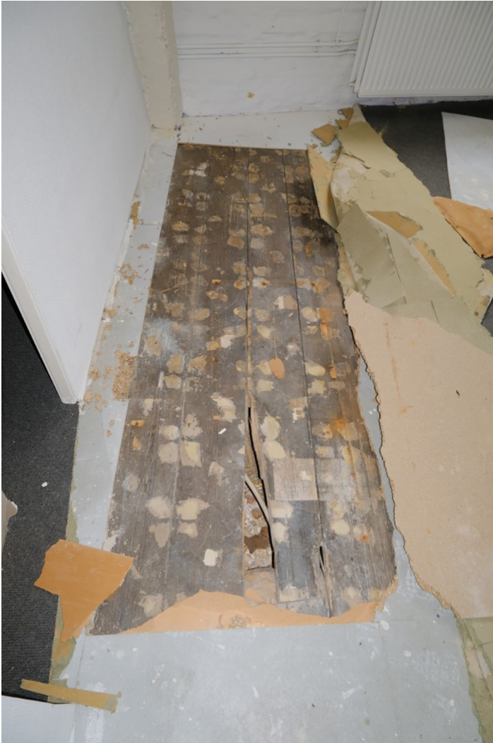
Gedeelte van de zoldervloer waarvan de enkelvoudige balklaag evenwijdig aan de voorgevel loopt.
