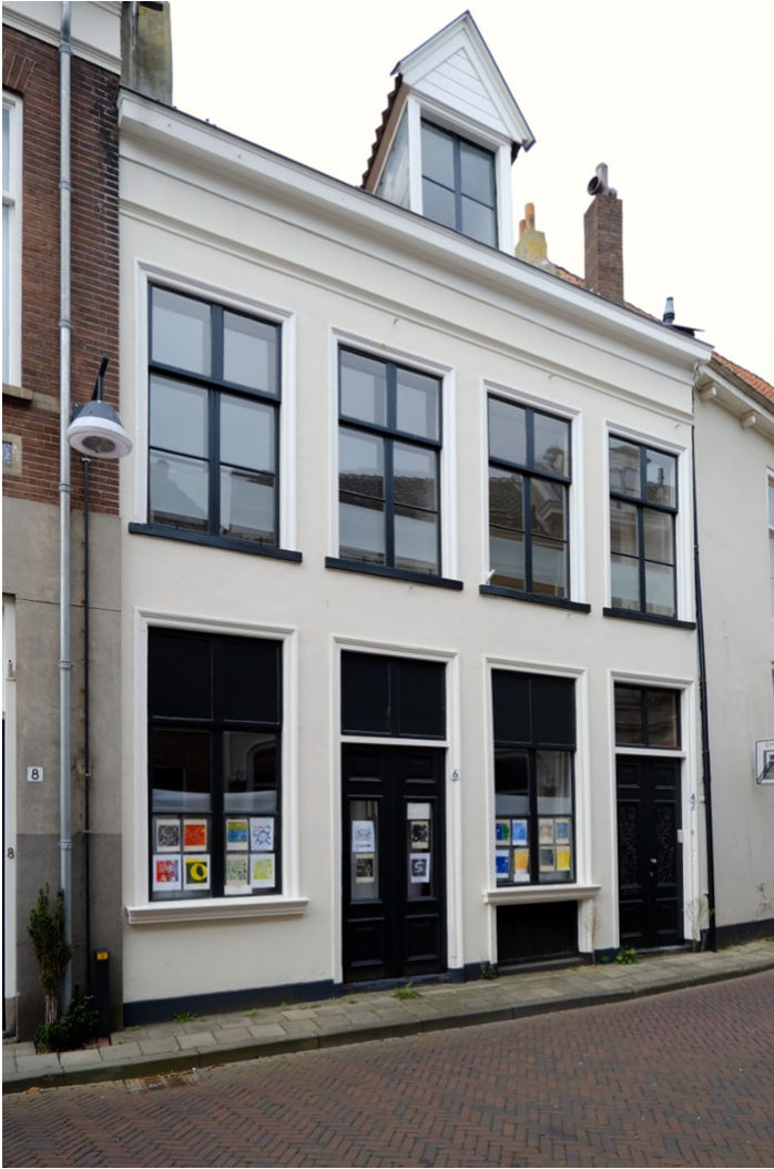
Overzicht van de voorgevel van Oudewand 4-6.
