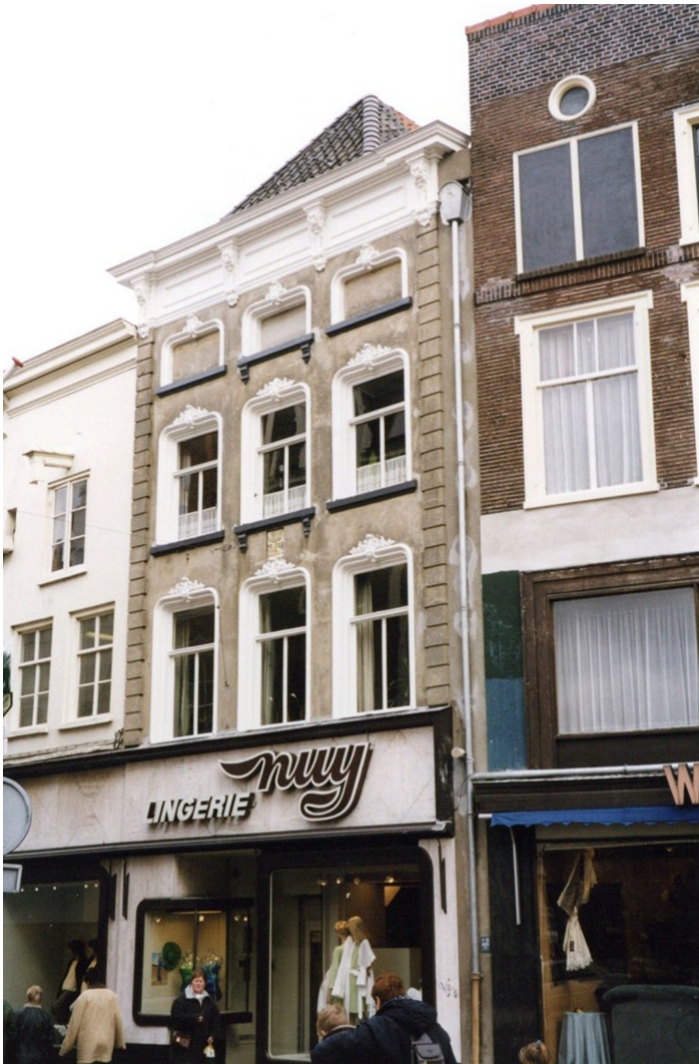
De voorgevel van Korte Hofstraat 2 in de periode dat de lingerie afdeling van het modehuis Nuy aldaar gevestigd was. (Erfgoedcentrum Zutphen, datum onbekend)
