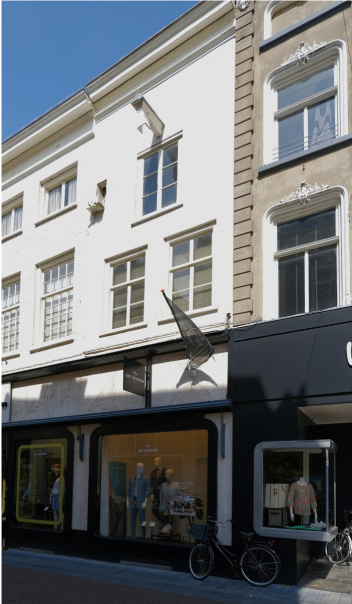
Voorgevel van de Korte Hofstraat 4.
