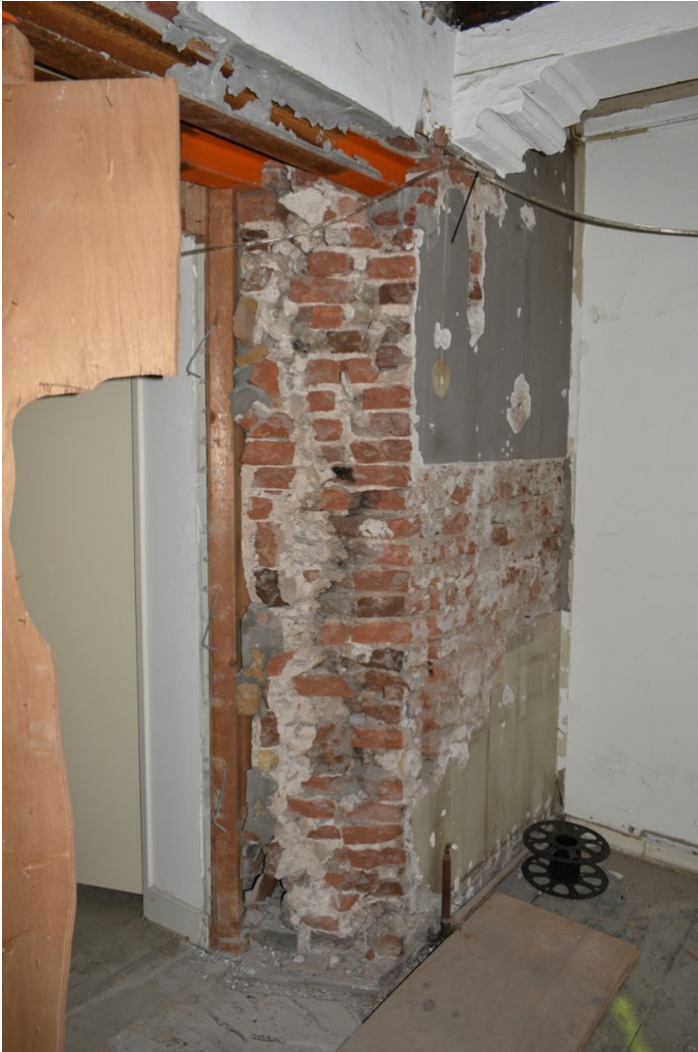
Doorbraak in de linker bouwmuur op de verdieping.
