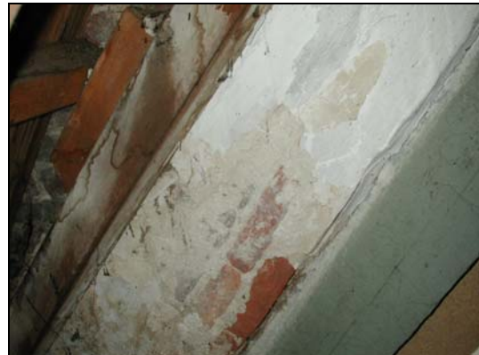
Detail van de aansluiting van het metselwerk op het westelijke spantbeen van spant 1. De bovenzijde van het gepleisterde metselwerk loopt in de lijn van de aanlopers ter plaatse.
