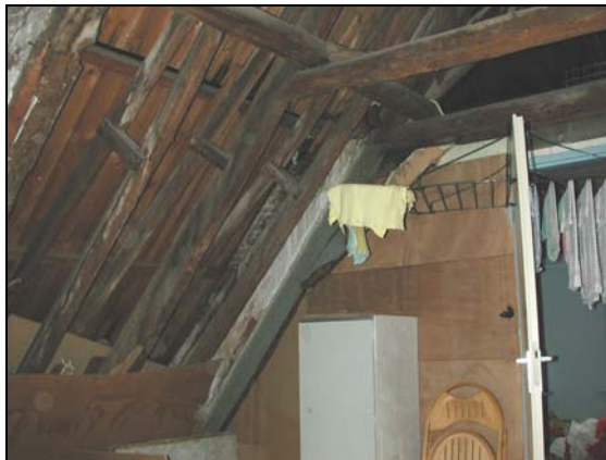
Westzijde van spant 1. Dit spant staat in het verlengde van het opgaande metselwerk van de achtermuur van de vertrekken op zolder.
