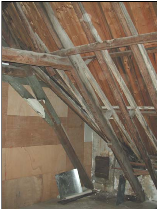
De oostelijke spantbenen van de spanten 1 en 2. Opvallend is de kleine tussenruimte. In een lichtere houtkleur zijn de aanlopers goed te zien die bij het verhogen van de borstwering noodzakelijk werden.
