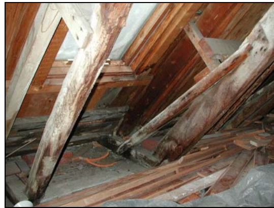
Overzicht van de zolderborstwering ter hoogte van getekende doorsnede B. Aan de rechter zijde van het dakvenster is het oostelijke spantbeen van spant 4 voorzien van een lange (verdwenen) en een korte aanloper. In de huidige dakbedekking is deze overgang nog steeds als sprong zichtbaar.
