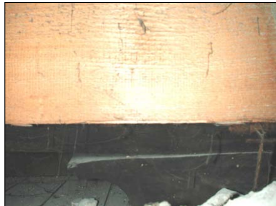
Achter een moderne balk is een donker geschilderd sleutelstuk waarvan de onderzijde is afgezaagd nog net zichtbaar.
