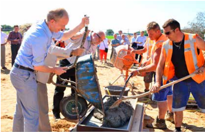
Starthandeling project ‘aanleg nevengeul Vilsteren’
