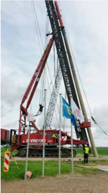
Officiële ‘eerste’ paal voor Windpark Battennoert in Nieuwe-Tonge
