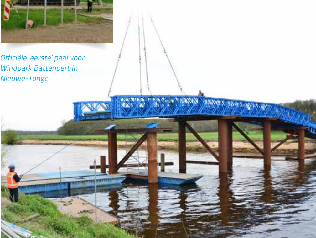
Plaatsen tijdelijke brug over de Vecht voor afvoer zand nevengeul Vilsteren
