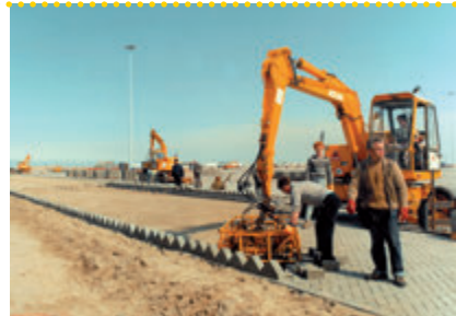
Aanleg complete terreinverharding ECT Delta terminal fase I
