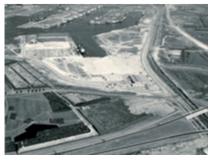
Waal-Eemhaven begin jaren '70 terreinaanleg door LBS
