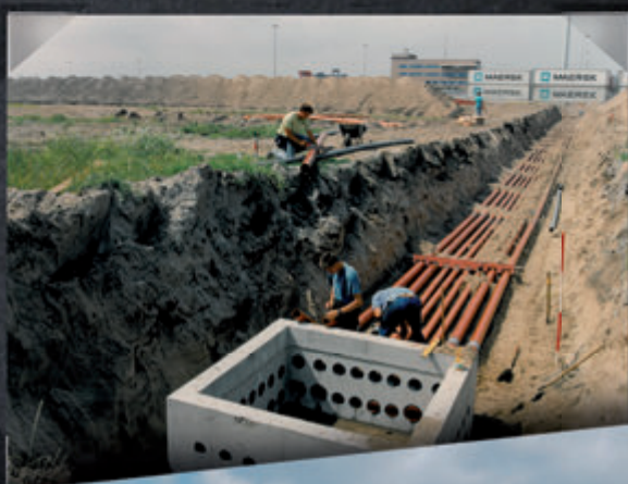
Aanleg mantelbuisentrac terminal Delta Sealand op Maasvlakte Rotterdam, 1990, Kantoor ECT op achtergrond.
