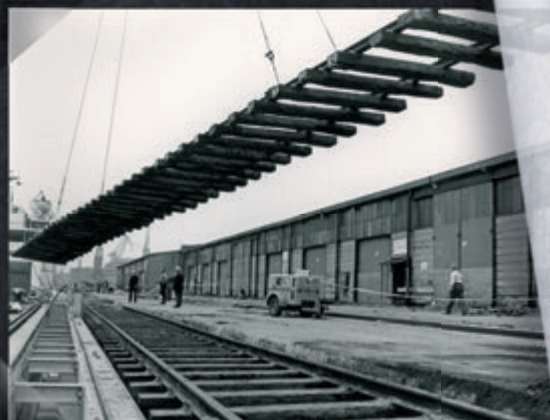
Reconstructie kade strook en spoor, Merwehaven Rotterdam, begin jaren '70.
