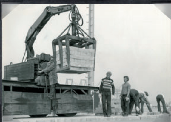
ECT Home terminal Rotterdam Waalhaven, aanbrengen verharding met 12 cm betonstraatstenen - toen nog handmatig, midden jaren '70.
