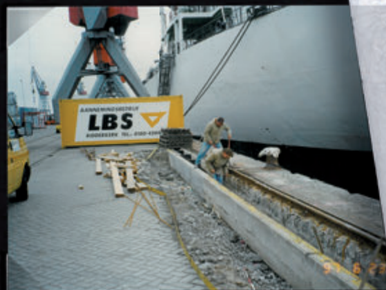
Stroomgoot tegen bestaande kademuur ten behoeve van stroomvoorziening nieuwe kranen, terminal Seaport (later ITR) Merwehaven Rotterdam, 1997.
