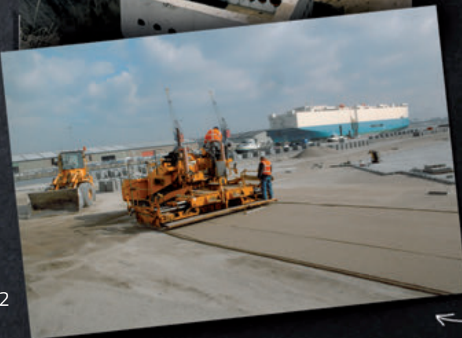
Stroomgoot tegen bestaande kademuur ten behoeve van stroomvoorziening nieuwe kranen, terminal Seaport (later ITR) Merwehaven Rotterdam, 1997.
