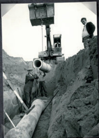
Aanleg riolering ECT Home terminal Rotterdam Waalhaven, begin jaren '70.
