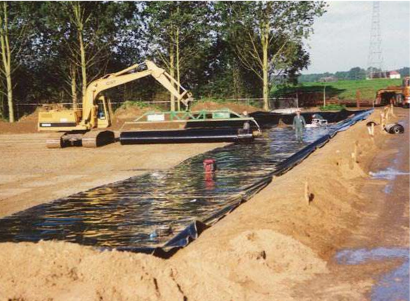
Aanleg van folie voor het depot van zuiveringsilb aan de Letlandsestraat in Zutphen
