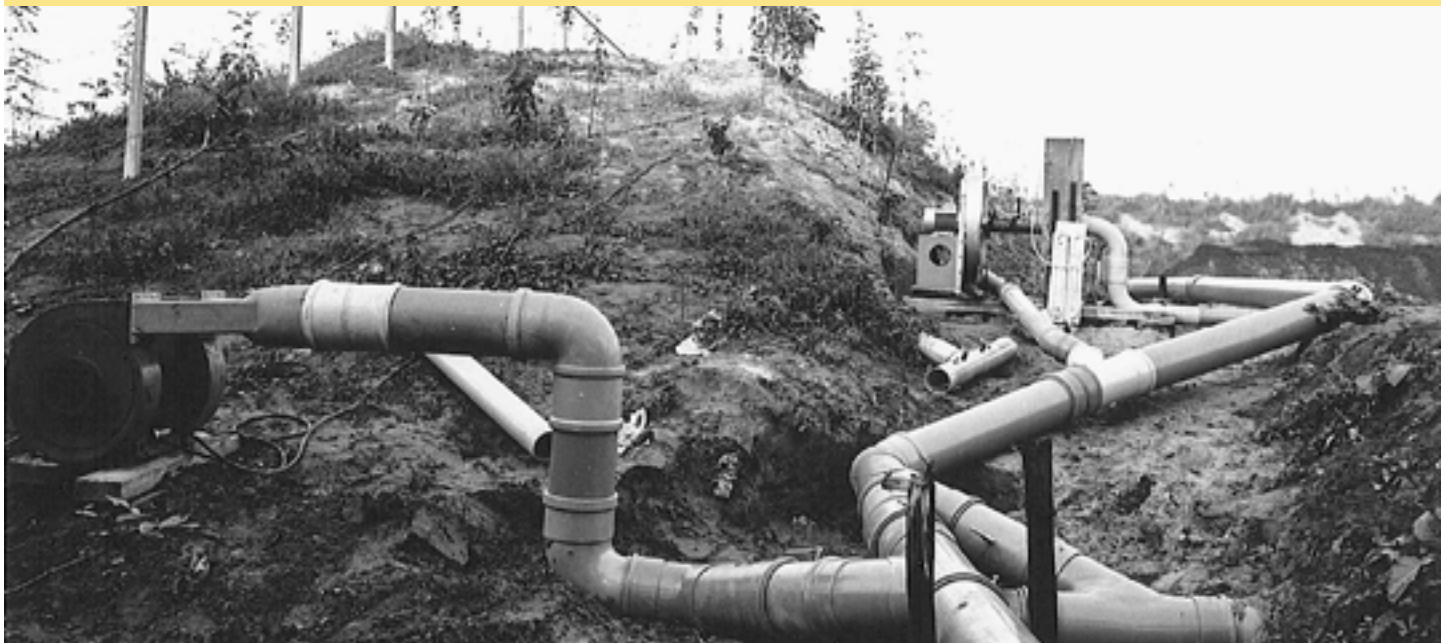
Met een grote ventilator en buizen werd lucht door de rillen geblazen
