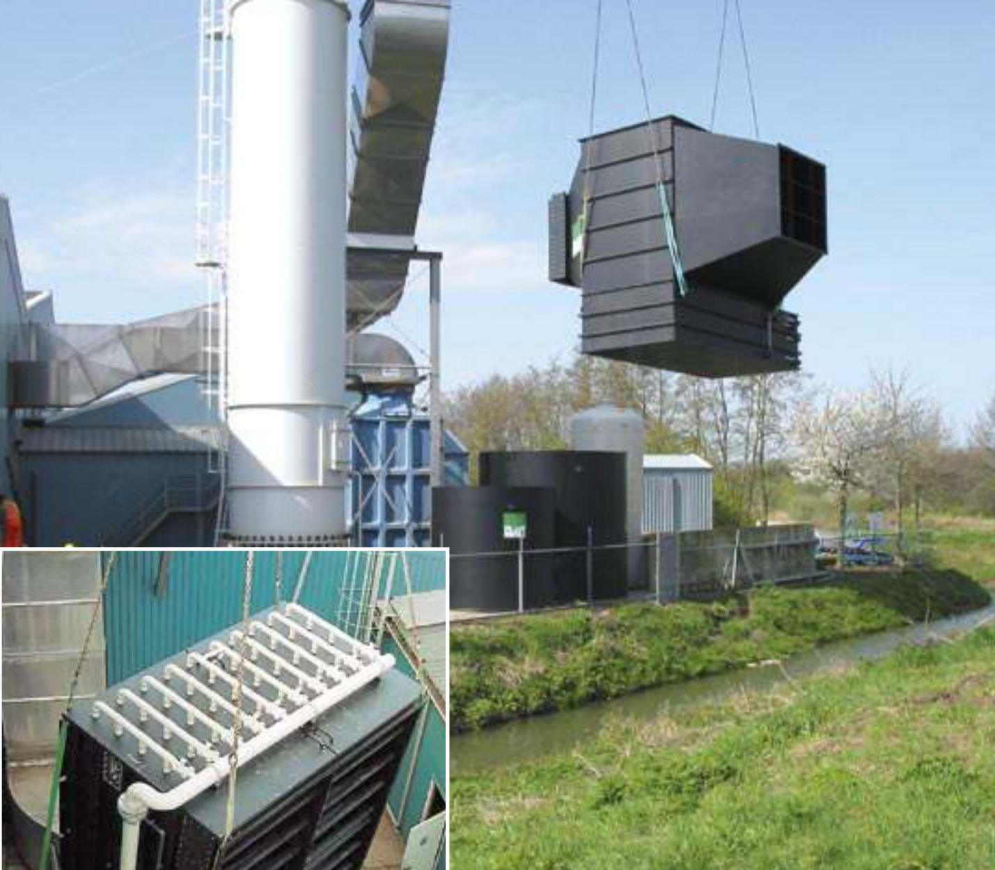
Plaatsing van de chemische wassers in Tiel (boven) en Zutphen (onder)
