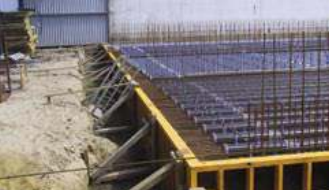
De aanleg van een composteringstunnel
