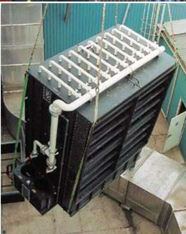
Plaatsing van de chemische wassers in Tiel (boven) en Zutphen (onder)
