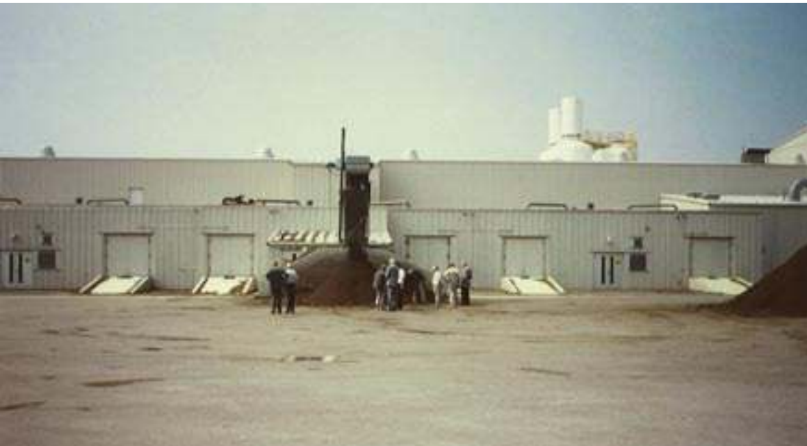
De achterkant van de slibcomposteerinrichting van Hamilton (Ohio) met zes tunnels. In het midden de uitvoer van de compost
