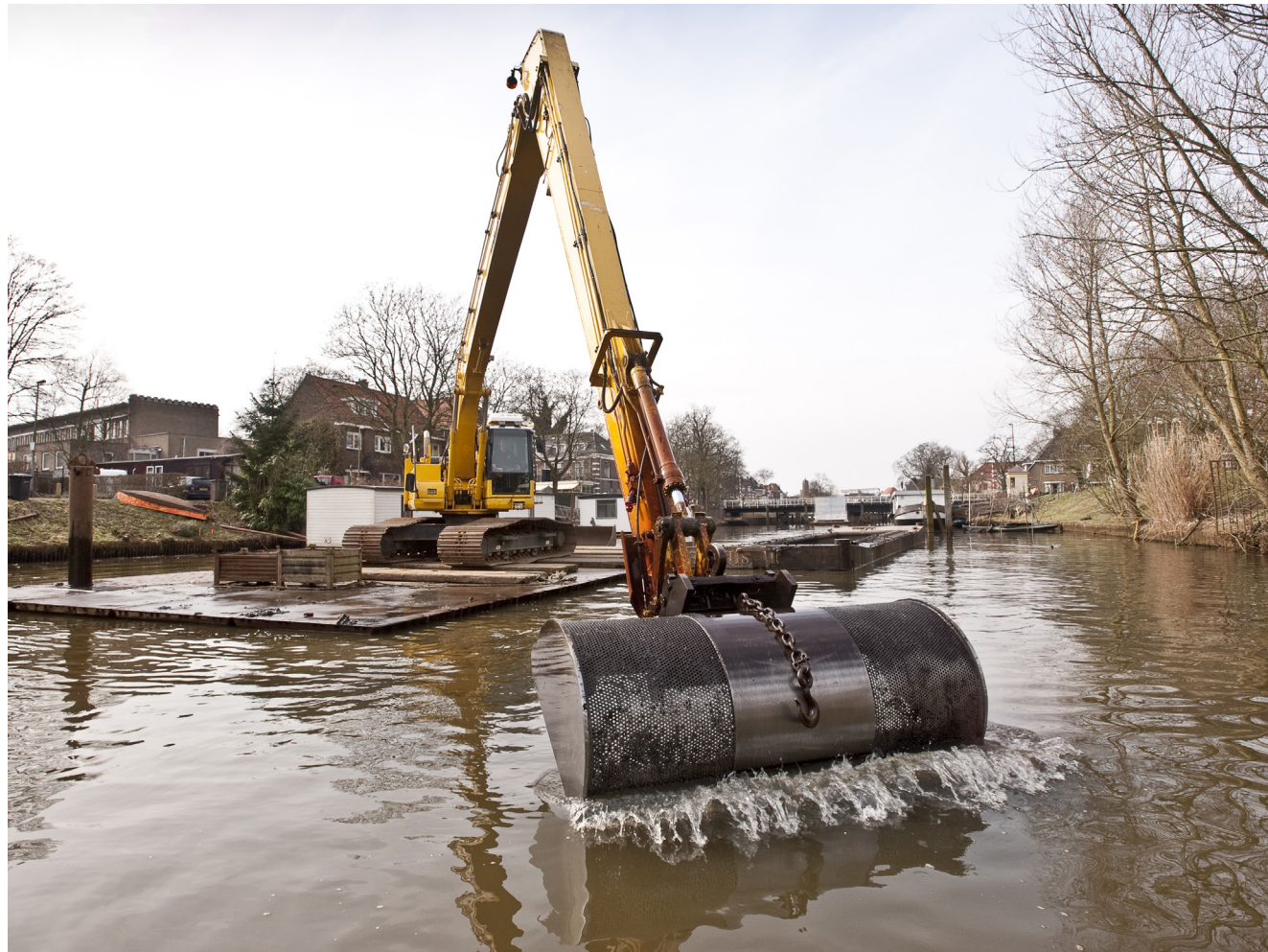
Een rupskraan baggert een kanaal uit.
