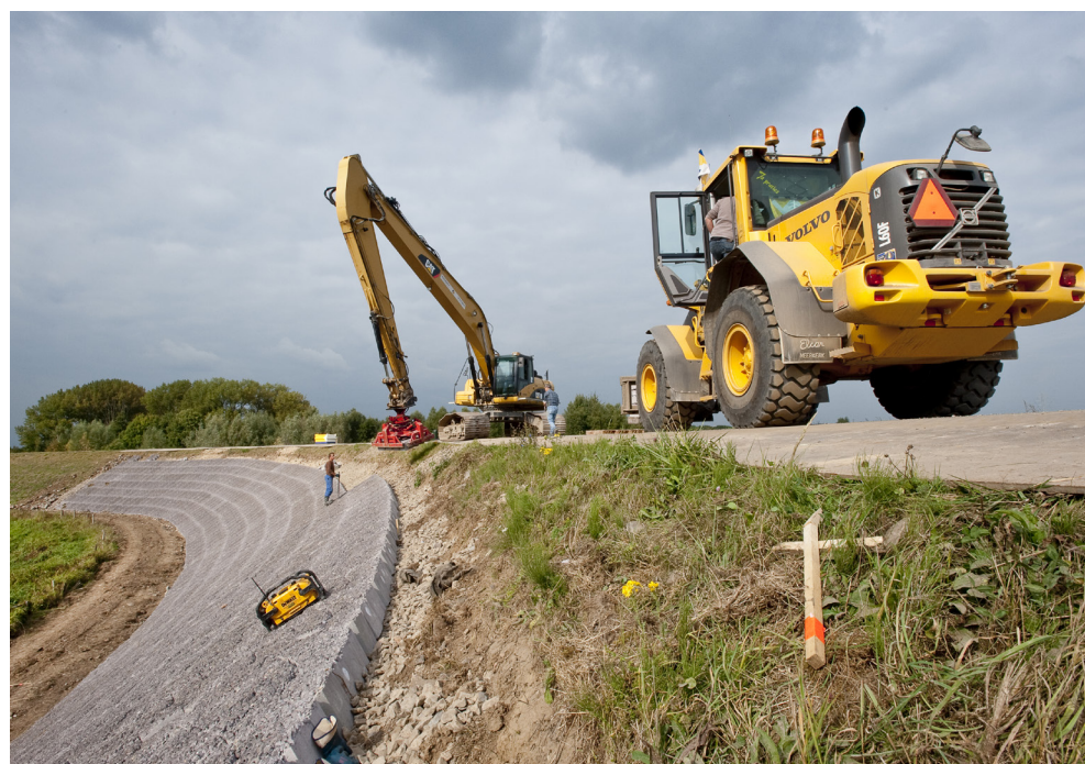
Dijkherstel met behulp van groot materieel.
