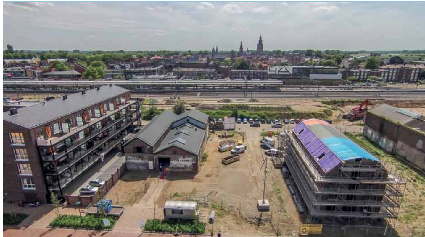
Het Pakhuis en de Broodfabriek naderen de voltooiing.
