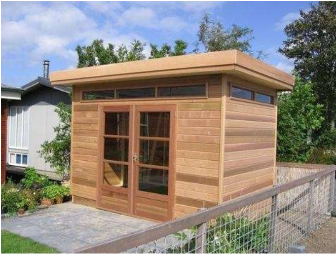
Plat dak (dak afschot 2 graden)
