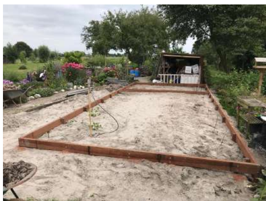
Hardhouten ringbalk met piketten fundering bouwwerken
