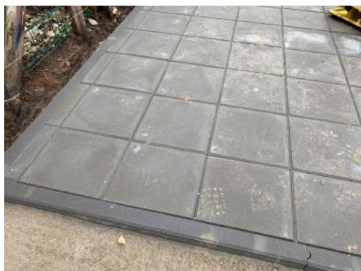
Opsluitbanden met bestrating
