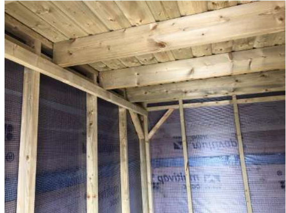
Wand isolatie voorbereiding
