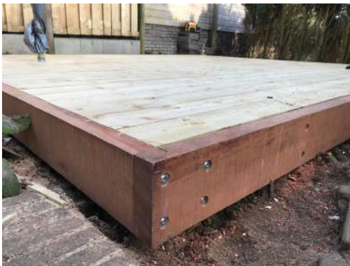
Hardhouten ringbalk met piketten en een houten vloer
