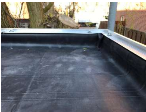
Dak opstand met daktrimmen
