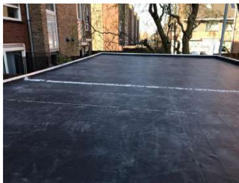
Epdm dak rubberfolie
