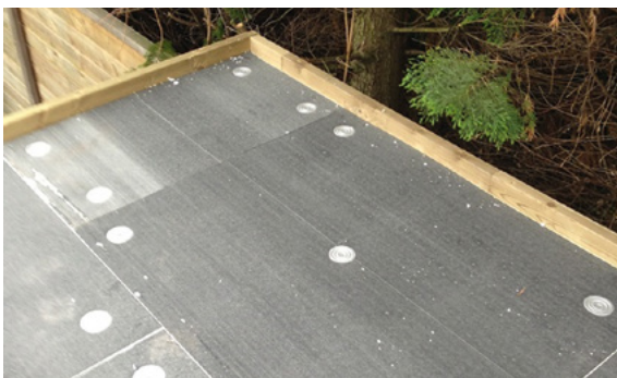
Plat dak isolatie
