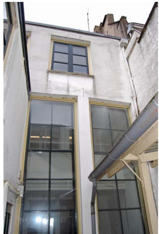
De achtergevel van het onderzochte huis met links de aanbouw.
