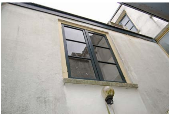
De onder- en bovenzijde van de zijgevel van de aanbouw aan de achterzijde van het pand.
