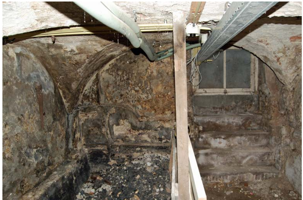
De kelder met kruisgraatgewelven onder het gedeelte linksachter van het onderzochte huis. Aan de linkerkant is de voormalige kolenopslag zichtbaar. Rechts de oorspronkelijke keldertrap naar buiten richting de Ossenmarkt.
