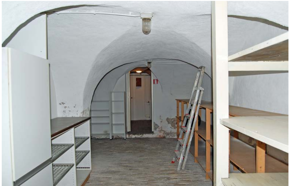
De kelder met kruisgraatgewelven onder het voorste gedeelte van het onderzochte huis.
