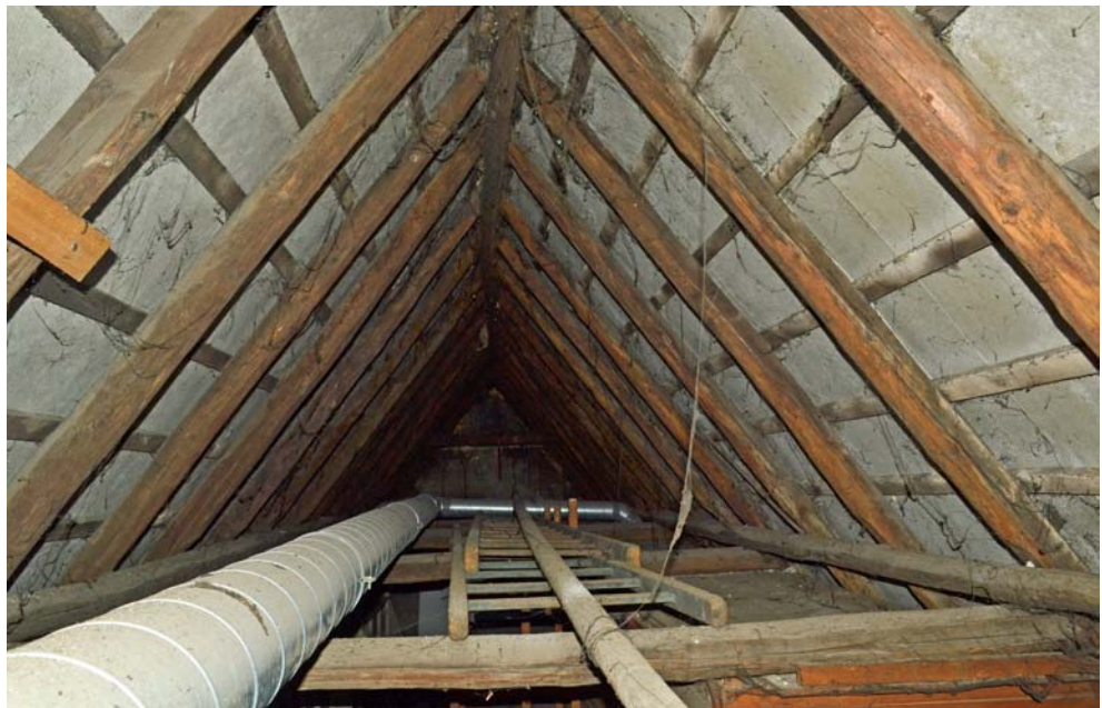
Overzicht van de kapconstructie, bestaande uit rondhouten daksporen, voorzien van haanhouten en boven de haanhouten onderling verbonden. Gefotografeerd in de richting van de Luttekestraat.
